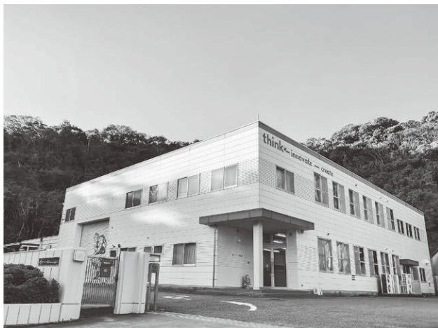
株式会社東洋バルブ製造所 本社
